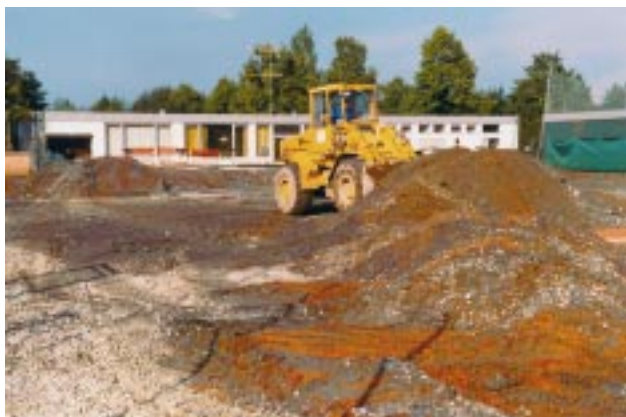
Sanierung der Plätze
